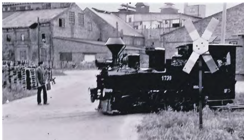
Brigadelok 1739 überquert in den 80-er Jahren die Teichstraße vor der Kulisse des stillgelegten Farbglaswerkes Weißwasser. Rechts im Bild die ehemalige Kartonagenfabrik. (Foto: Sammlung Matthias Mätzig)
