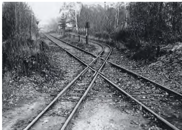
Niveaugleiche Kreuzung des Schmalspurgleises, von der Ziegelei in der Jahnstraße kommend, mit dem Normalspurgleis zur Brikettfabrik Weißwasser. (Foto: Bernd Krasel)
