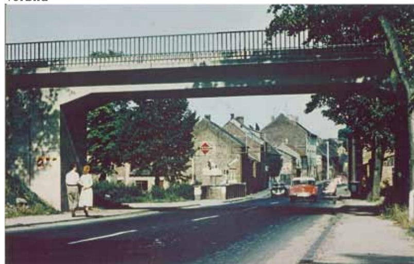
Brücke Alt Mödrath Vorbild
